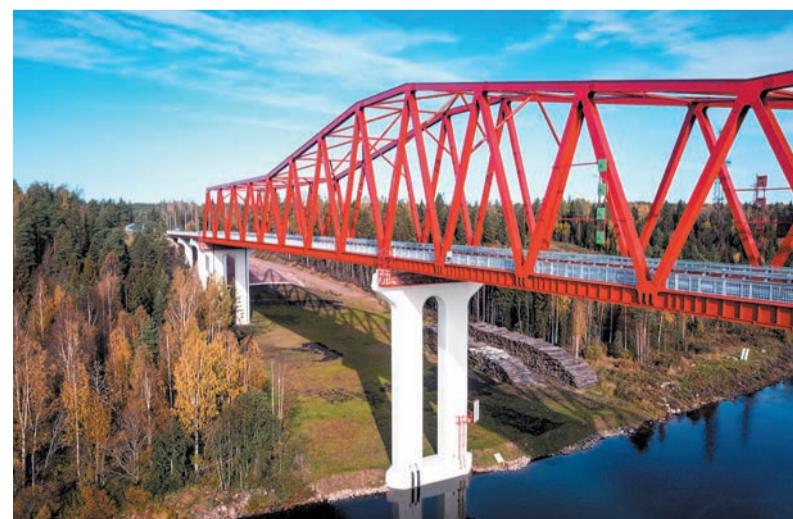
В Ленобласти продолжается строительство и ремонт мостов
