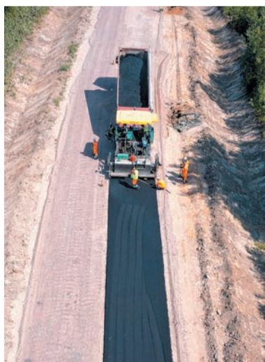
В планах на 2024 год — ремонт 200 км автодорог
