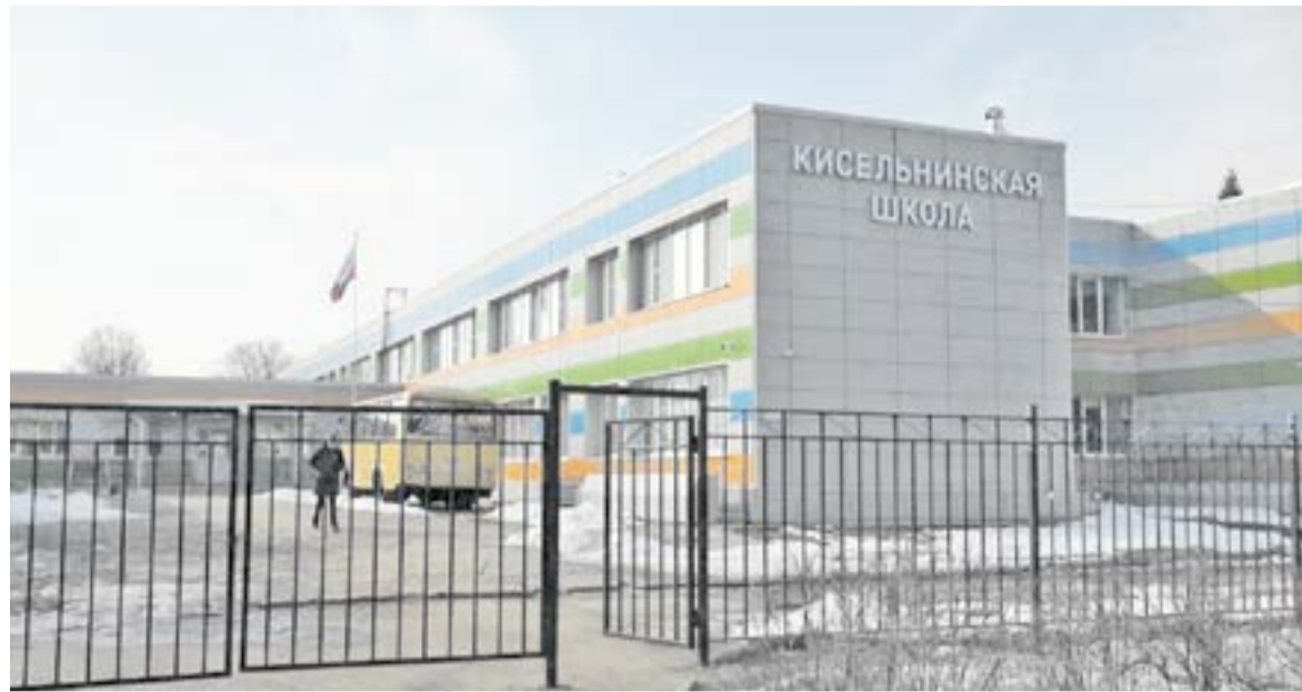
← В 2024 году завершён ремонт фасада Кисельнинской школы
