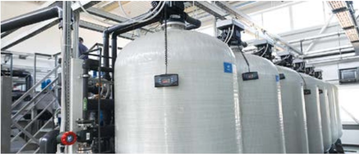
↑ Новые водоочистные сооружения ежегодно строятся по всей Ленобласти в рамках федеральной программы «Чистая вода»
