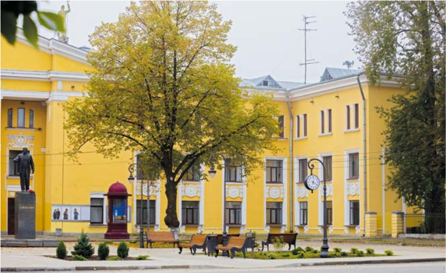
← Работы на площади Ленина с учётом реставрации памятника завершатся к декабрю 2025 года
