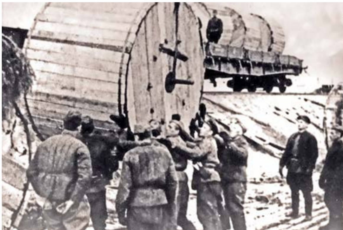
↑ Подготовка к укладке кабеля на дно Ладожского озера. 1942 г.
