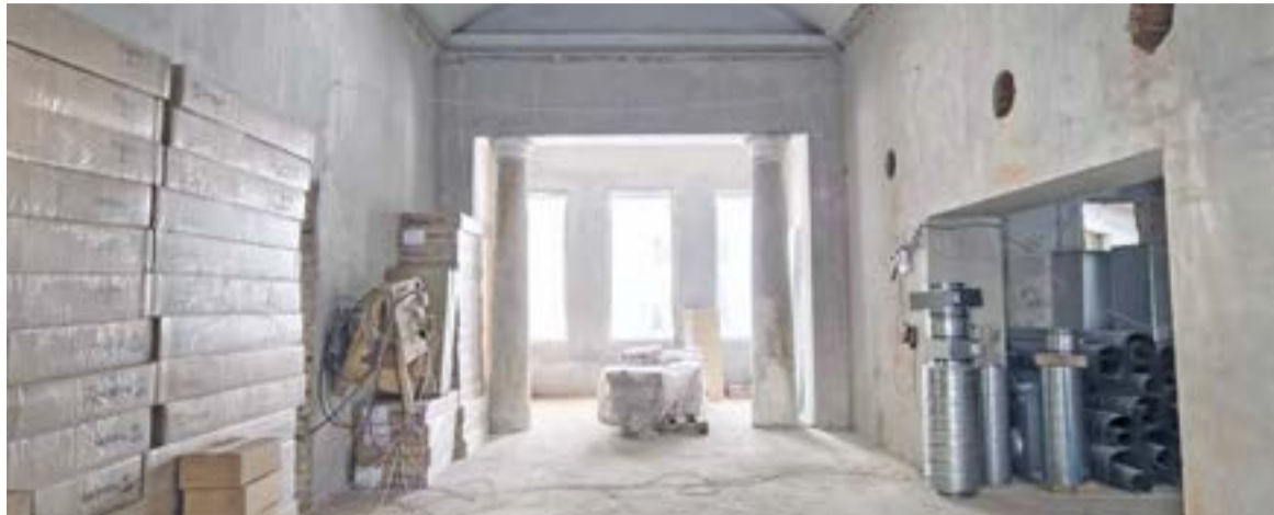
↑ Капитальный ремонт дома культуры — первое серьёзное обновление здания 1956 года постройки
